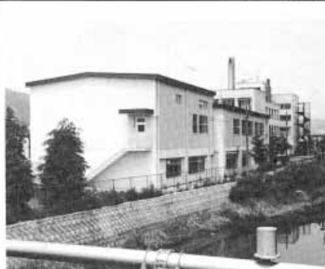
第3号館延長工事完成
