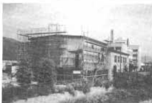
第3号館延長工事
