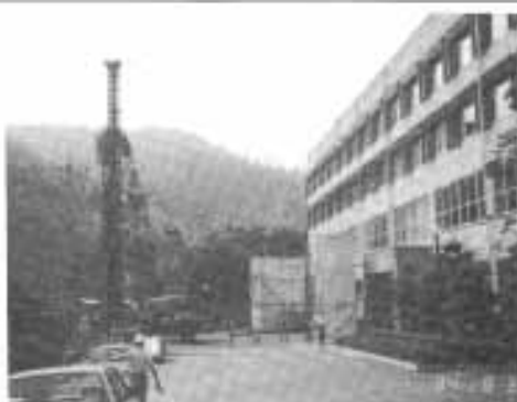
第4号館建設打ち。
