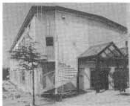
整備成った第3号館
